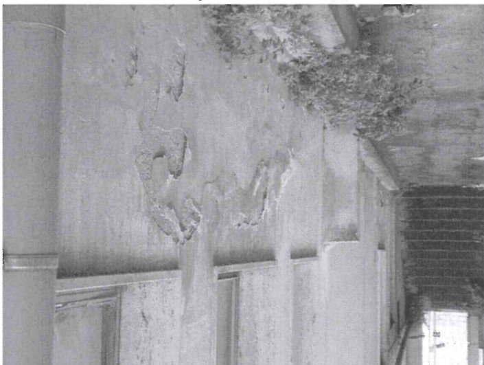
Murature interne ed esterne
